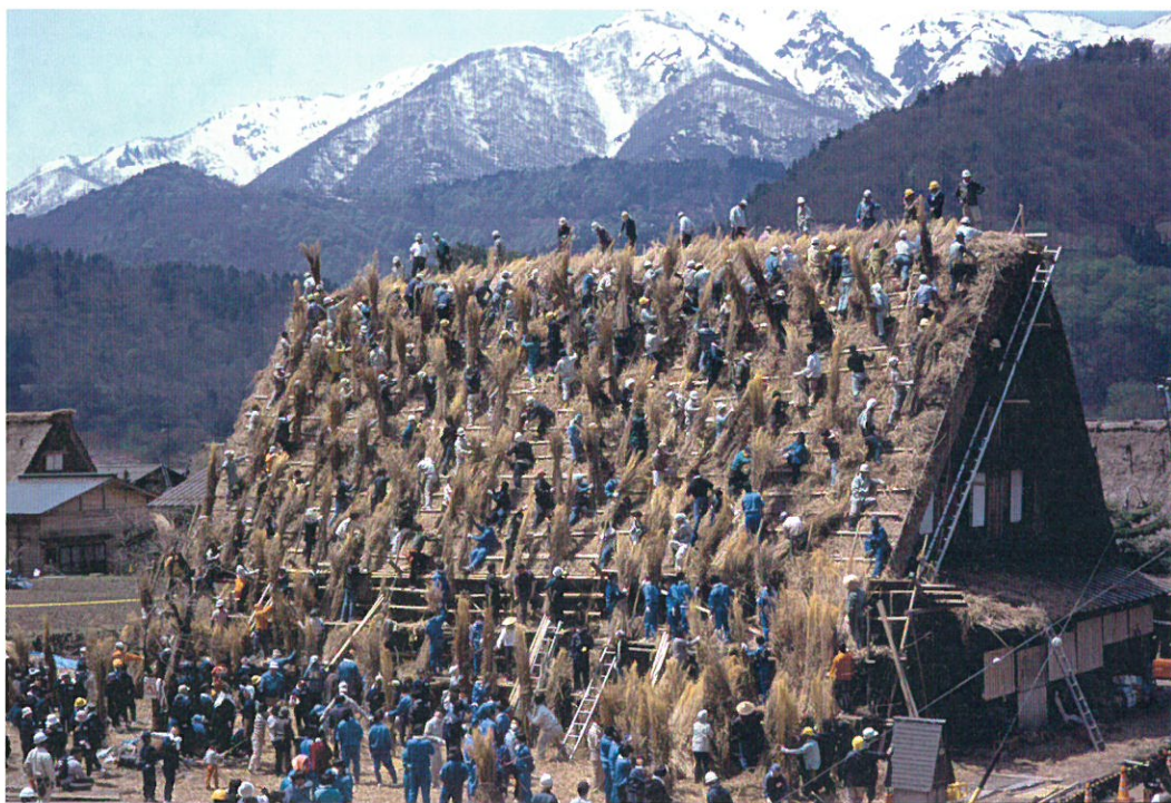
屋根のふき替えの様子
