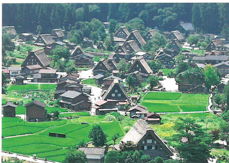
妻面が皆ほぼ同じ南北方向を向いている
