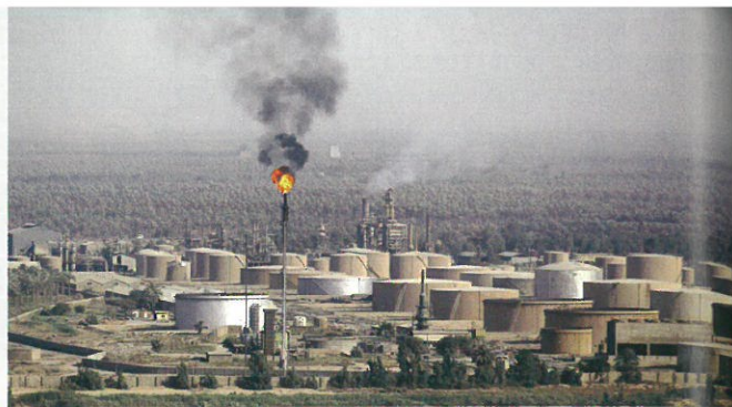
② 大規模な石油施設(2008年、イラク)
