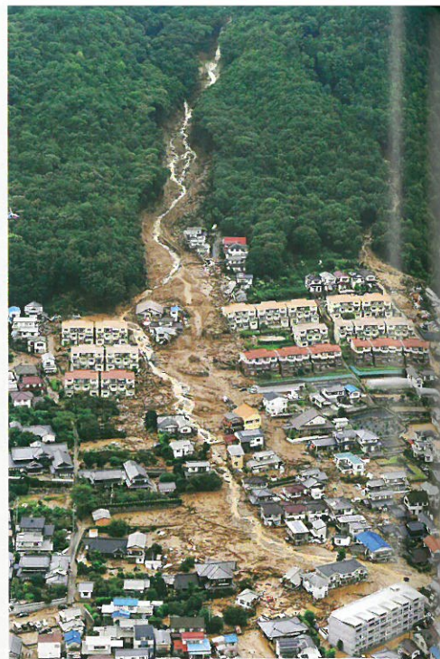
③ 土石流による災害 (2014年, 広島市安佐南区)
