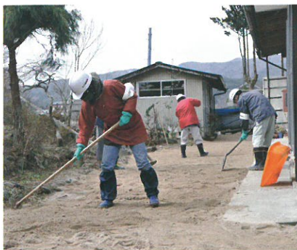
④ 除染作業のようす (2012年, 福島県川内村)
