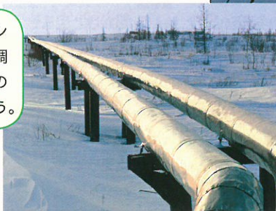
⑦パイプライン(2008年)
