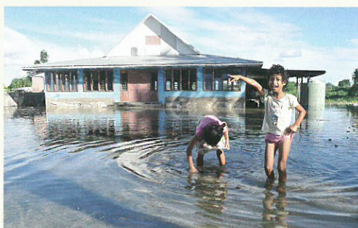
⑥ 高潮による冠水(2014年, ツバル)
