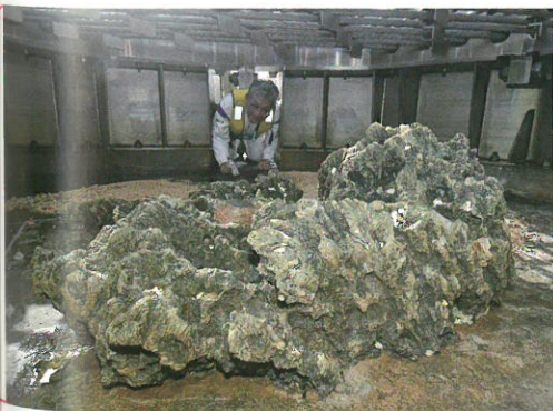
⑧ 護岸工事で保護された沖ノ鳥島 (2004年、東京都小笠原村)
