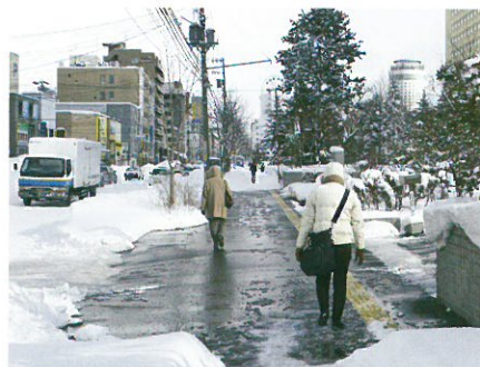
⑤ ロードヒーティングをしている歩道(2011年, 札幌市)
